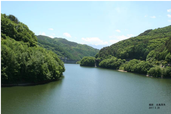
写真1 箕輪ダム全景
