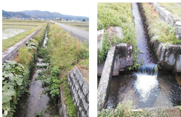
写真14 近代的な用水路（中川村田島）
