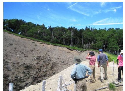
写真3 三伏峠南側、百間ナギと呼ばれている大規模な崩壊地
