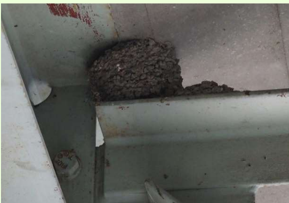
写真5 鉄骨とコンクリート面の間に造巣 天竜川 町田橋（下の図4のタイプ）
