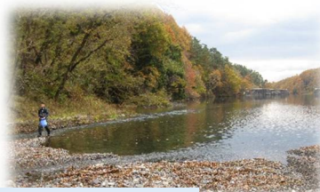
大泉川所砂防ダム
