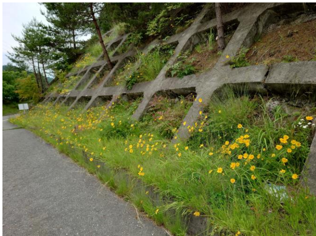
<箕輪ダム管理事務所付近の道路法面>
