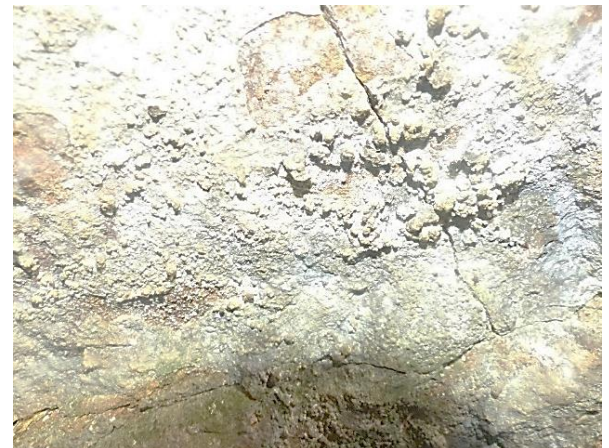
写真5-4 ひび割れたケイブコーラル
