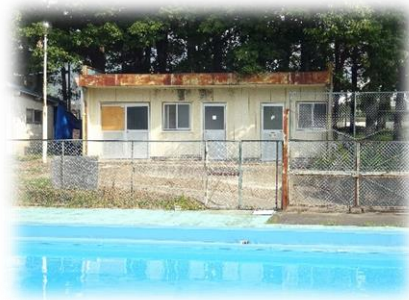
フールのトイレは敷地外
